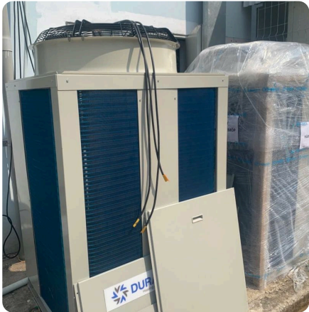
Bảo dưỡng dàn nóng tại nhà xưởng
