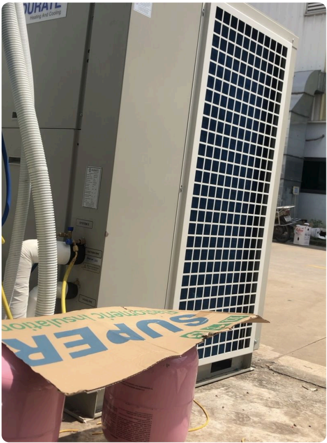
为 Durate AHU 室外机组加注 R410A 冷媒
