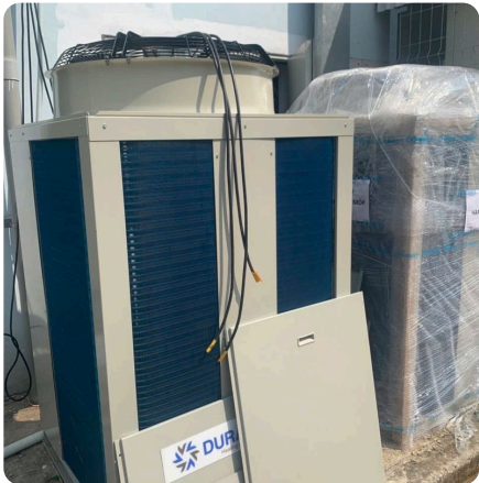
厂房室外机维护保养
