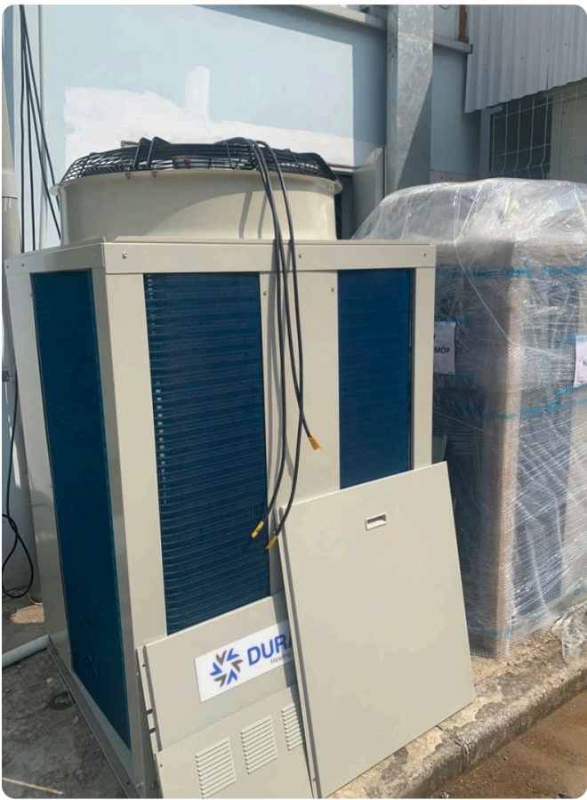
加注冷媒前打开 Durate AHU 室外机组外壳
